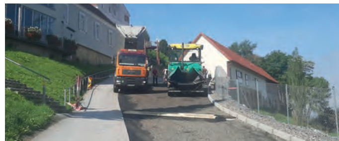
▲ Die Auffahrt zur Kinderkrippe wurde asphaltiert
