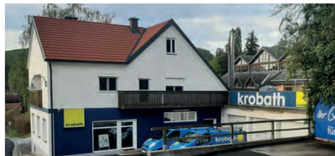
▲ Das sanierte Objekt Straden 58
