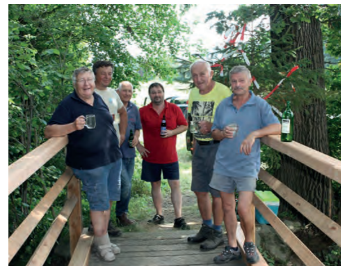
▲ Brückensanierung an der Fischaufstiegshilfe in Dirnbach
