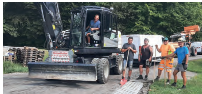
▲ Verlegung von Rasengittersteinen entlang der Gemeindestraße
