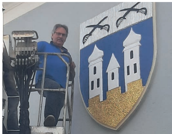
▲ Malermeister Johann Leitgeb passte das Wappens an der Außenmauer des Gemeindeamtes an die neuen Farben an
